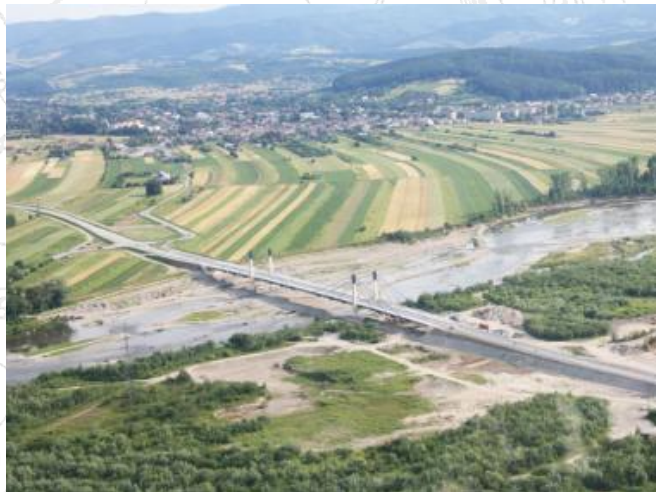
Widok z góry (źródło: ZDW Kraków)
