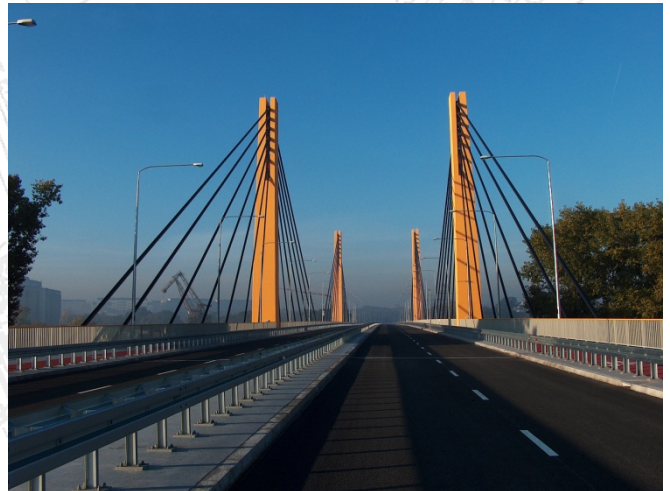
Widok na płytę pomostu
