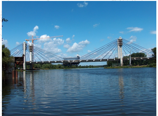
Obiekt w budowie
