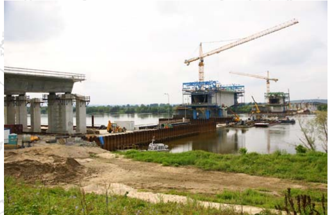
Segmenty startowe mostu głównego
