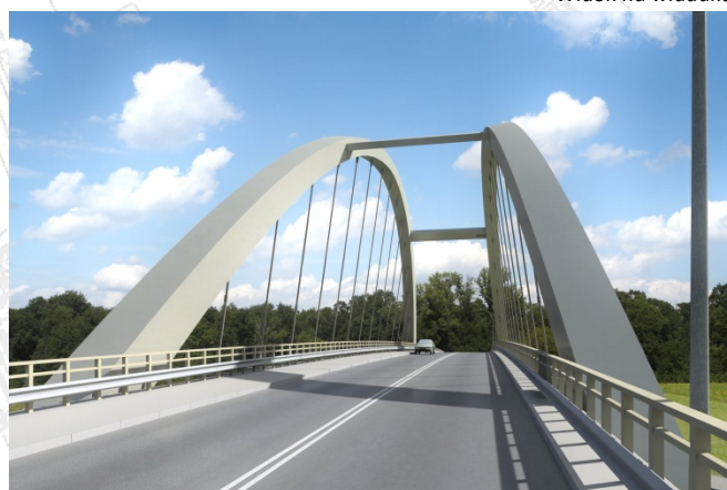
Widok na płytę pomostu
