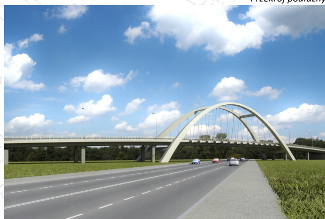
Widok na wiadukt
